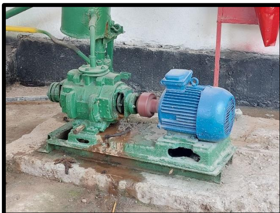
Рис.2 Вакуумный водокольцевой насос ВВН-3
