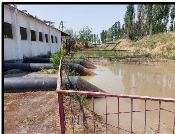
Рис.1 Оросительная насосная станция «Ангор-2», напорные и всасывающие трубопроводы
