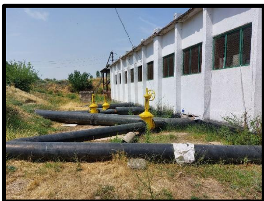
Рис.1 Оросительная насосная станция «Ангор-2», напорные и всасывающие трубопроводы
