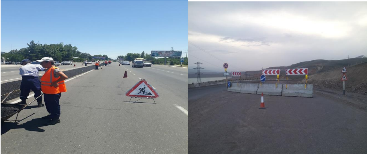
3-rasm. Ta'mirlanayotgan yo'l bo'lagidagi yo'l belgi va to'siqlarni o'rnatilgan holati.
